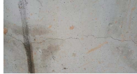
02 균열 체크, 사진 촬영 (카메라 저장)
